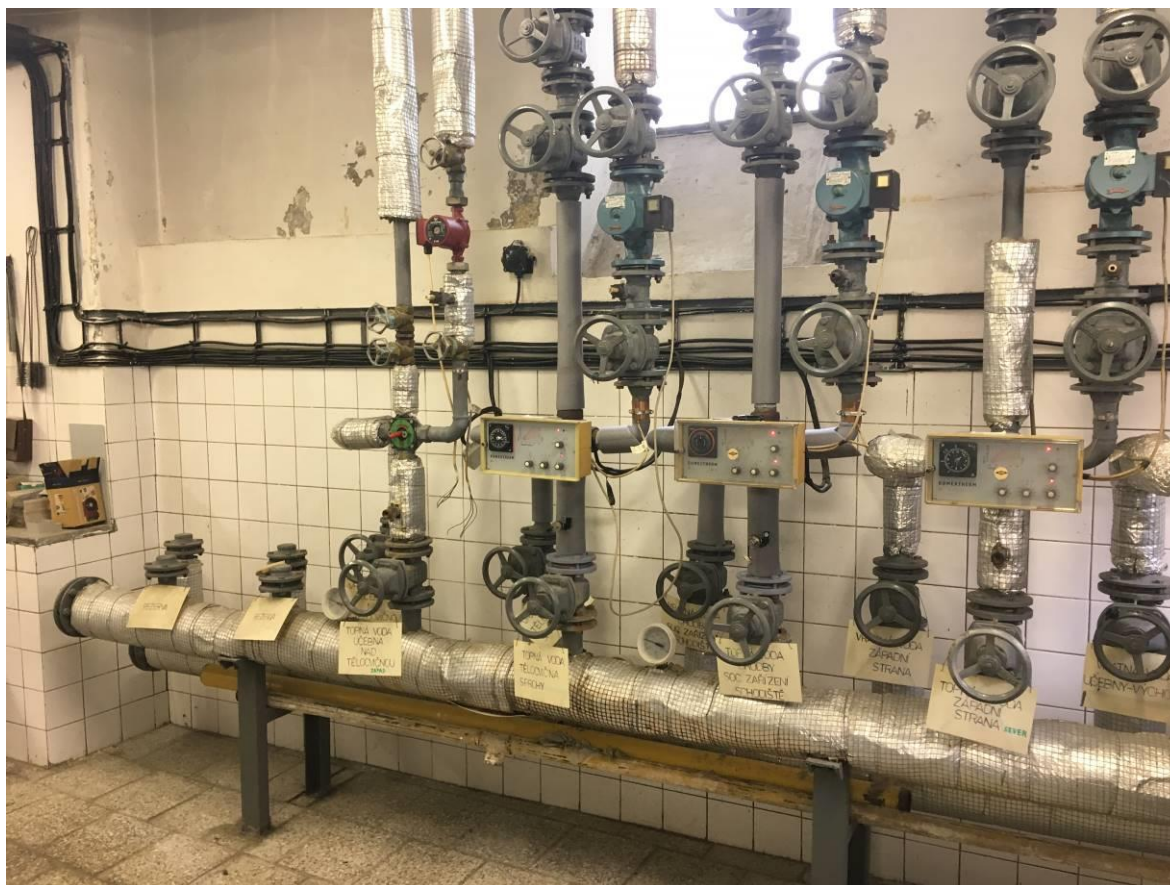
Foto č. 2 – pohled na stávající rozdělovač topné vody
